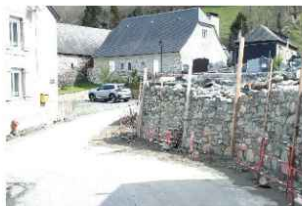
Travaux en cours
